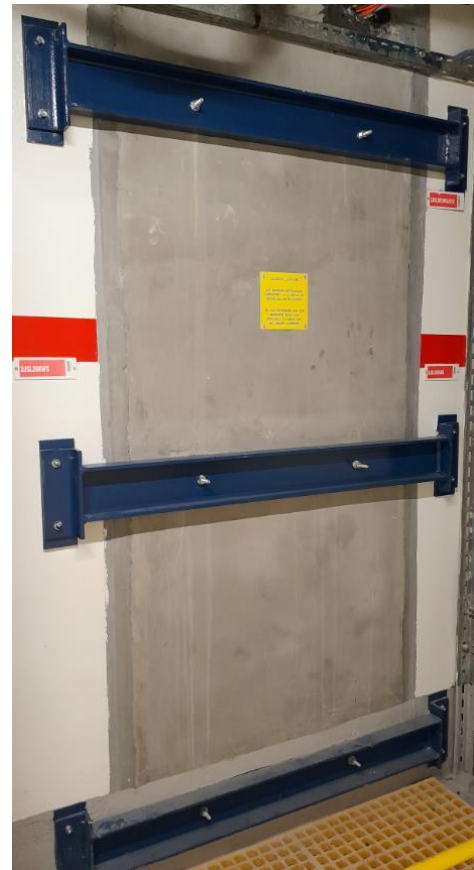
Renforcement des cloisons
