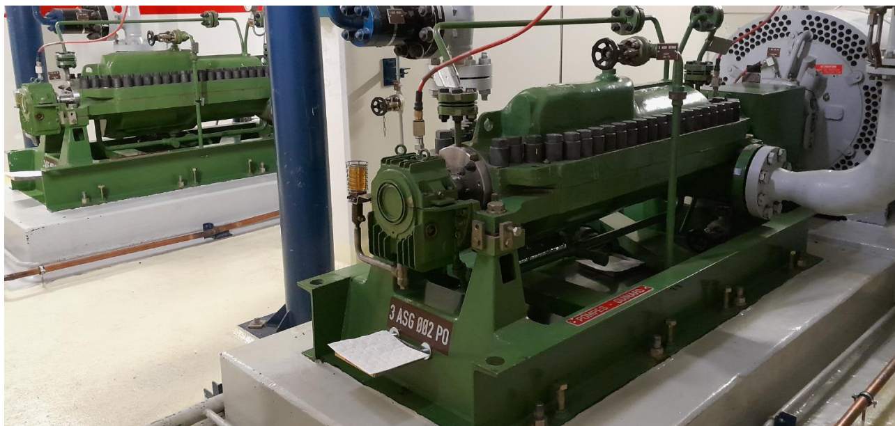
Motopompe d'alimentation en eau de Secours des Générateurs de Vapeur (ASG)
