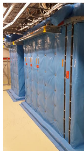
Mécatisage pour diminuer la charge calorifique
