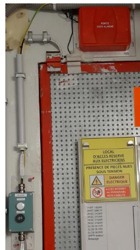
Porte équipée d'un dispositif d'alerte d'ouverture
