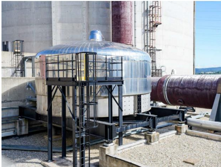
Dispositif U5 d'éventage de l'enceinte
