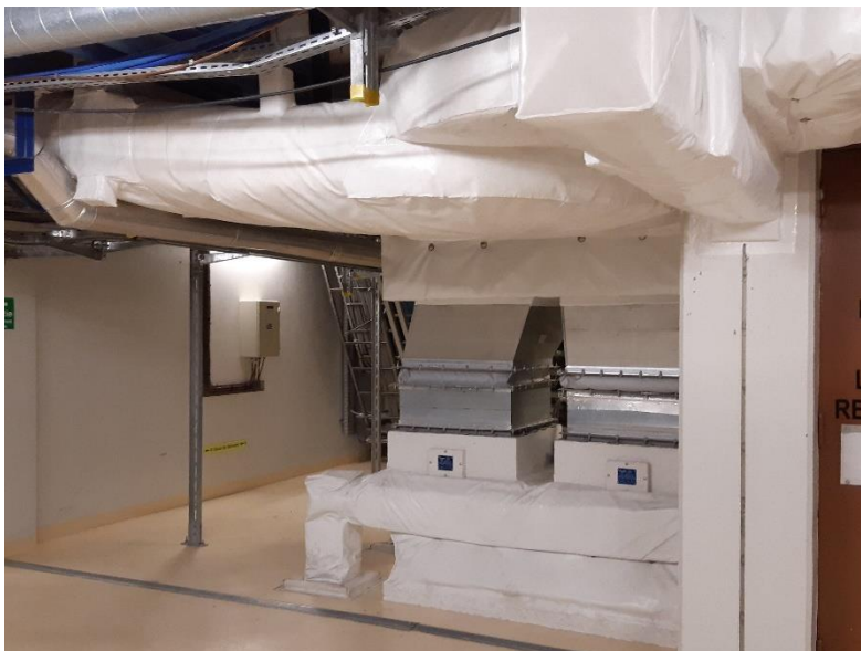
Exemple de protection de chemin de câble
