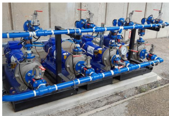
Pompes de surpression du système de brumisation
